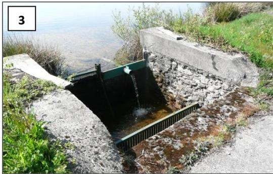
Ouvrage de restitution de l'eau depuis l'étang vers le cours d'eau, via un déversoir passant sous la digue (de type « siphon », avec grilles au niveau du déversoir)
